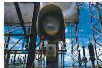
Monitor Gas Status ทาวเวอร์เดิมตาม มอนิเตอร์ใหม่ติดตั้ง
